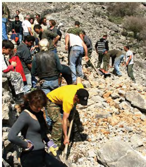
Κυριακή 13 Μαρτίου : Καθαρισμός - Συντήρηση - Επισκευή φαραγγιού Καλλικράτη
